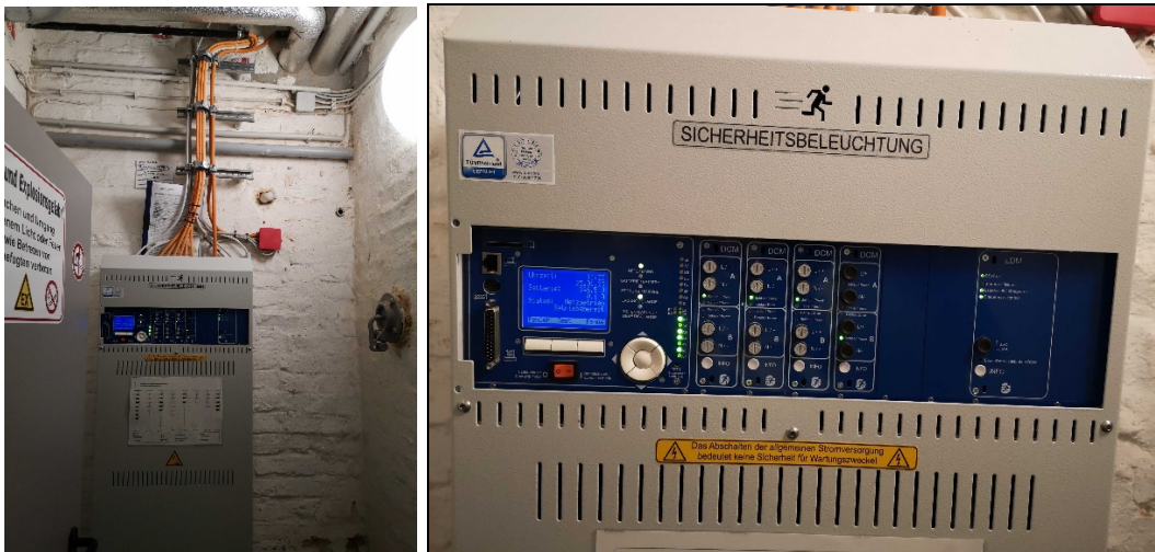
Abbildung: Zentralbatterieanlage
