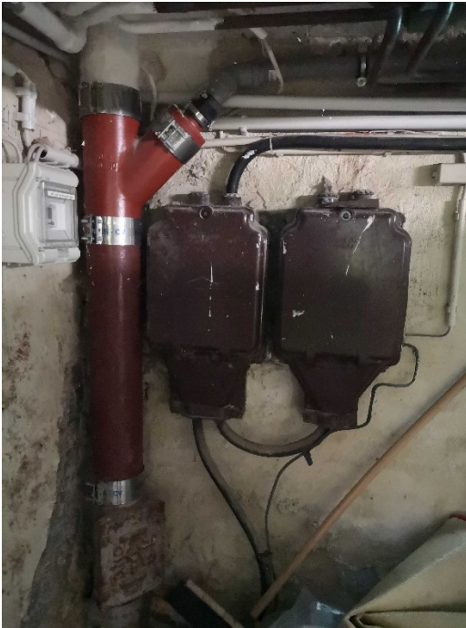
Abbildung: HAK (links) - Hauptverteiler (rechts)
